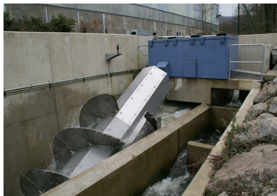
Figure 4 : vis hydrodynamique et son auge
